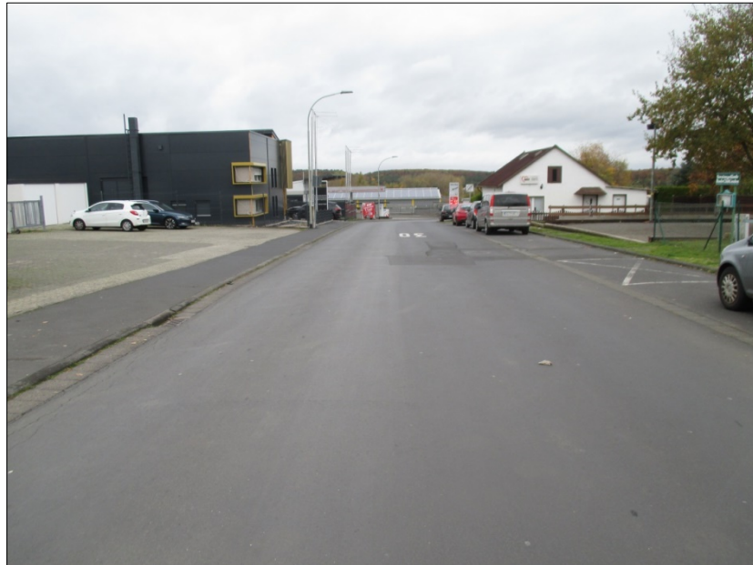
Bild 2: Sudetenstraße nördlich der Ludwigstraße (Blickrichtung Norden)
