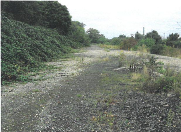
Bereich ehem. Gleisanlage, Auffüllung, Blick vom Bahnhof Richtung Norden (04.09.2020)
