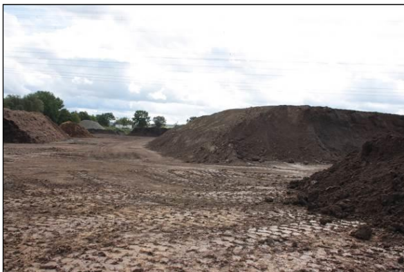
Abb. 5: Blick über das Gelände zur Aufbereitung und Lagerung von Mutterboden, Pferdemist und Zuschlagsstoffen.
