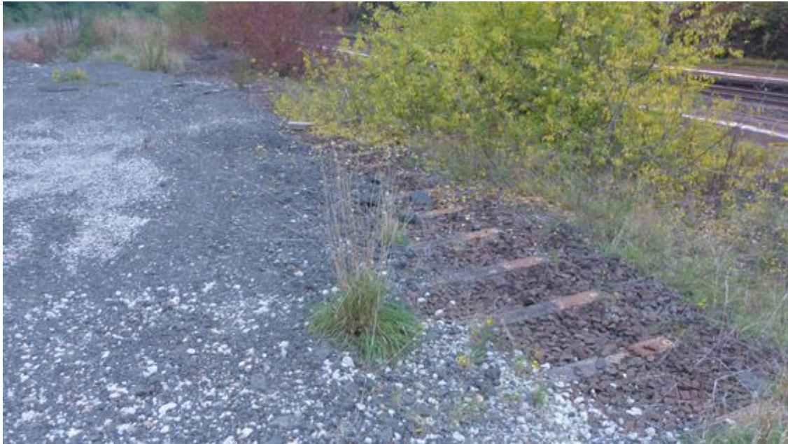
Abb. 12: ehemalige Gleise im Abkipfbereich
