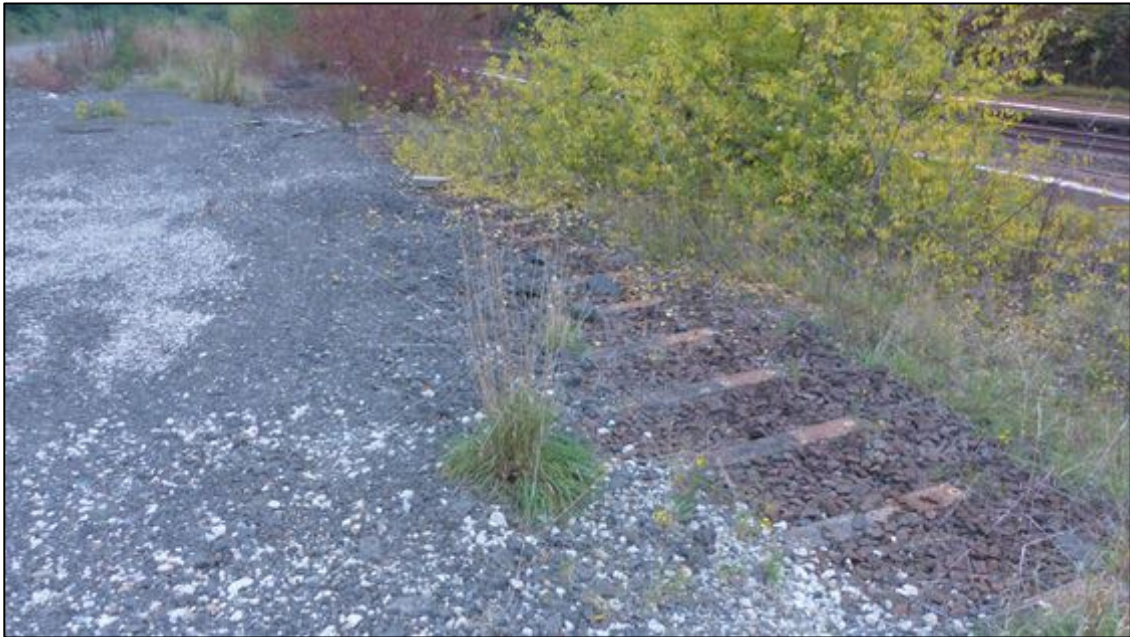
Abb. 12: ehemalige Gleise im Abkippbereich
